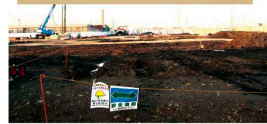
和光市新設小学校建設工事現
